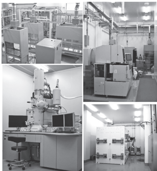
図2 整備の進む原型炉 R&D 棟。 左上：RI 実験室のフード等、左下：微細構造装置群室に据え付けられた透過型電子顕微鏡、右上：ベリリウム製造設備室、右下：材料試験室に据え付けられた簡易しゃへい体（セル）
