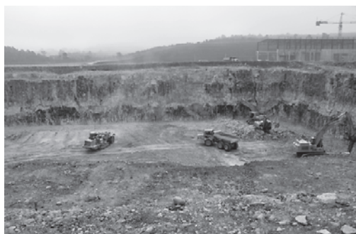
図 1 ITER トカマク複合建屋ピットの掘削工事がほぼ完了(2011年2月, ITER 機構提供)。
