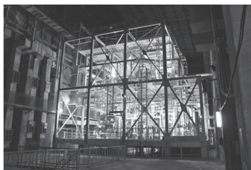
図3 組み立て工事が終了した大洗リチウムループ(原子力機構大洗工学センター)。
