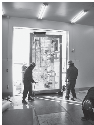
図3 原型炉 R&D 棟への実験設備の据付開始 (平成22年3月28日)
