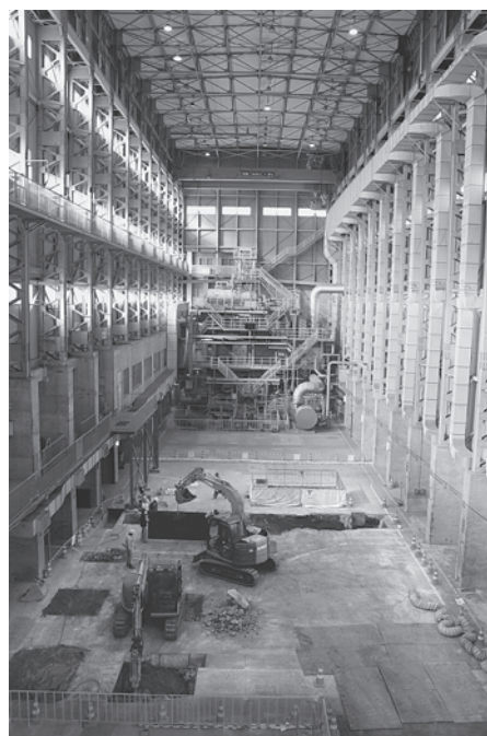
図2 IFMIF/EVEDA のLi試験ループ現地工事 (平成21年11月10日、原子力機構大洗研究開発センター)
