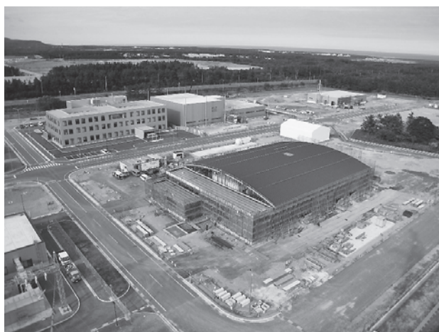
図2 施設の建設が進む国際核融合エネルギー研究センター (平成21年8月26日撮影)
