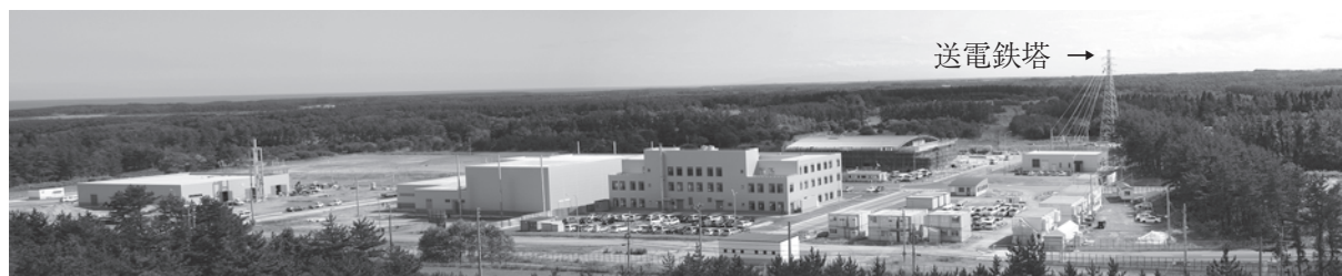
図1 施設の建設が進む国際核融合エネルギー研究センター （平成21年8月25日撮影）
