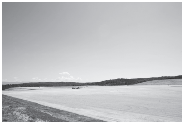
写真2 整地が終了したITER建設サイト(5月27日撮影)
