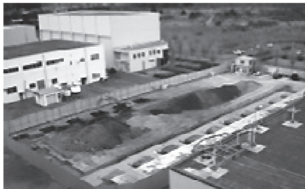
超伝導コイル巻線棟建設工事
