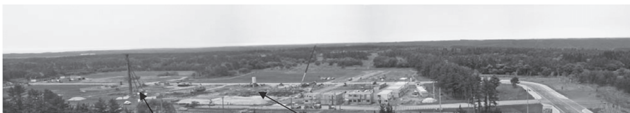
計算機・遠隔実験棟建築現場(杭工事中)
