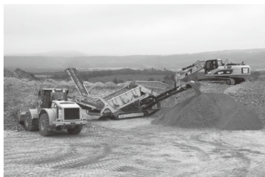
写真1 ITER建設サイトの整備作業が進展。
