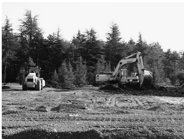
写真2 ITER建設サイトの整備状況 (ITER機構提供)
